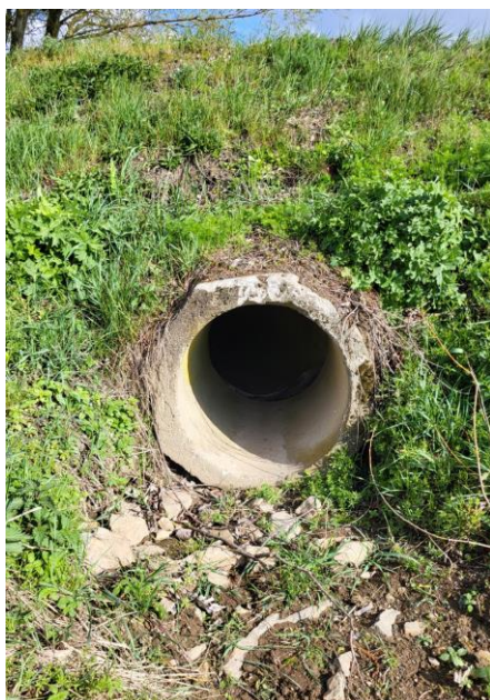
Propustek 6P – stávající vtokové a výtokové čelo
