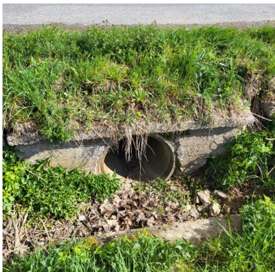
Propustek 8P – stávající vtokové a výtokové čelo
