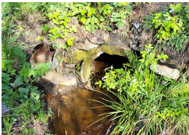
Propustek 5P – stávající vtokové a výtokové čelo
