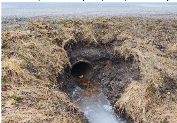
Propustek 2P – stávající vtok a výtok
